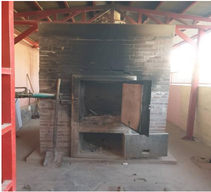
شکل ۴. نمای داخلی کوره شفاخانه ولایتی غزنی
